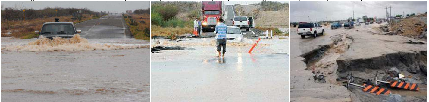
Figura 78. Vialidades cortadas y dañadas por las intensas precipitaciones generadas por la depresión tropical Jimena.
