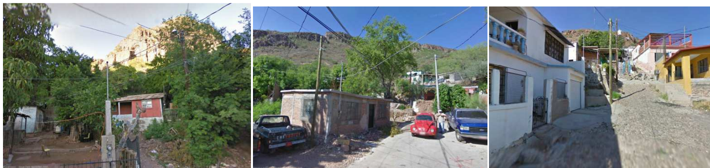
Figura 63. Viviendas en zonas de riesgo por derrumbes
