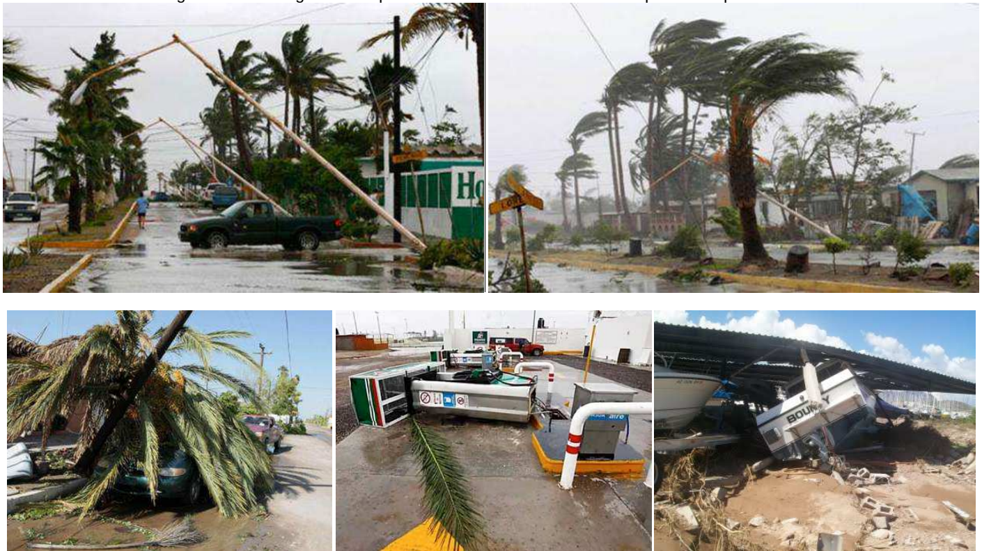
Figura 91. Daños generados por los fuertes vientos durante la depresión tropical Jimena
