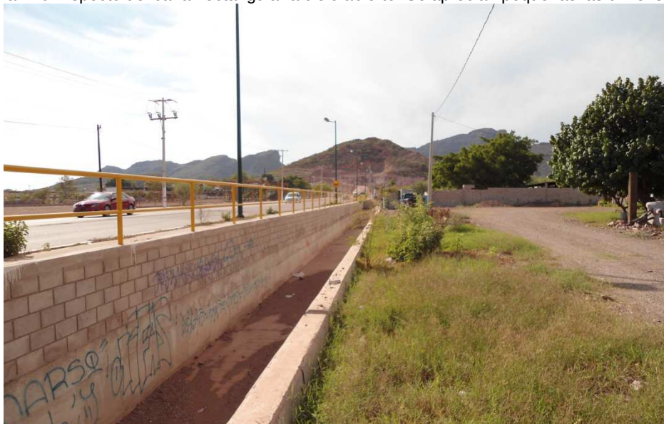
Figura 116. Aspecto del canal rectangular a cielo abierto. Se aprecian pequeñas las dimensiones
