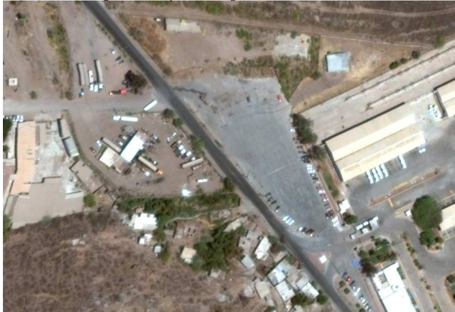
Figura 110. Aspecto del ingreso al ducto subterráneo
