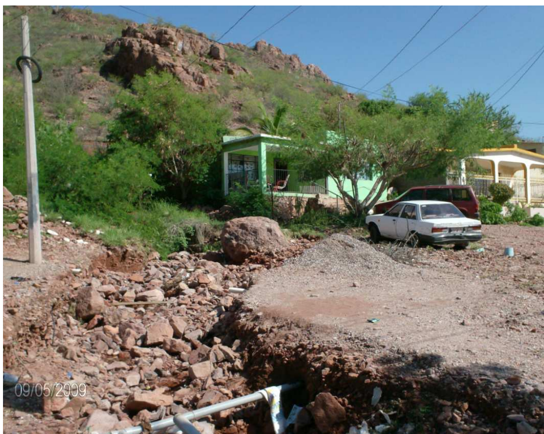
Daños por erosión hídrica en Viviendas asentadas en la colonia asentada en la falda del cerro Cabezón.
