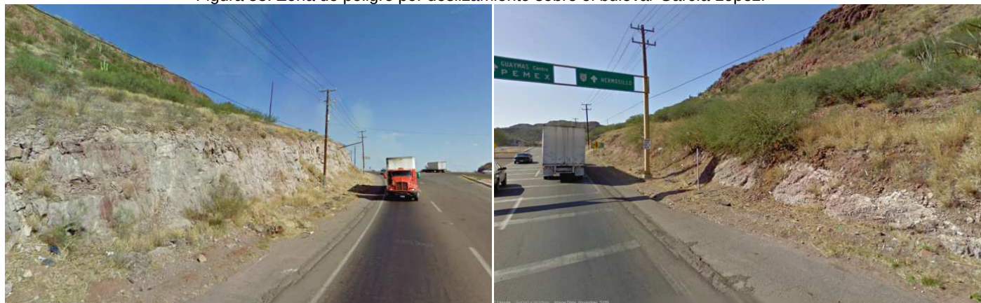
Figura 53. Zona de peligro por deslizamiento sobre el bulevar García López.
