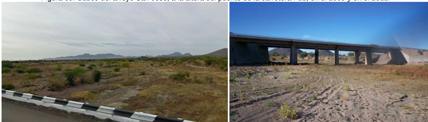
Figura 69. Cauce del arroyo San José, a la altura del puente de la carretera F15, en el 2009 y en el 2011.
