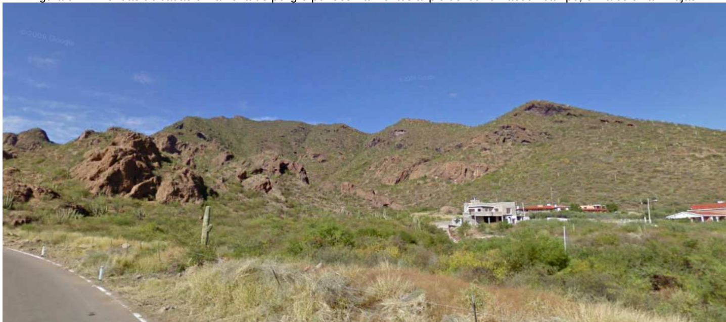
Figura 57. Viviendas ubicadas en la zona de peligro por deslizamientos al pie del cerro Bacochibampo, en la colonia Tinajas.
