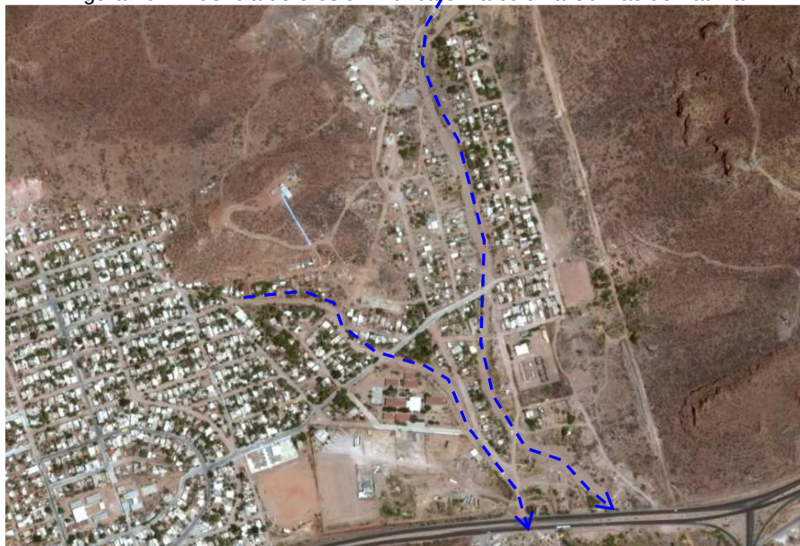
Figura 70. Evidencia de erosión hídrica en la colonia Colinas de Fátima
