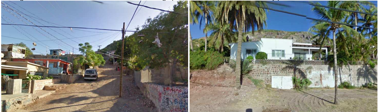
Figura 55. Viviendas asentadas en zona de riesgo por deslizamiento, en las faldas y pie del cerro La Cantera
