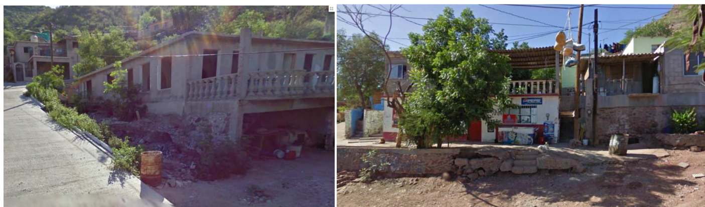
Daños por erosión hídrica en Viviendas asentadas en la colonia Guadalupe y en la falda del cerro Cabezón.
