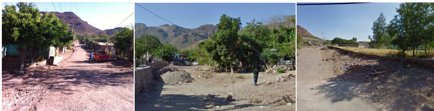
Viviendas asentadas al margen de escurrimientos de agua.
