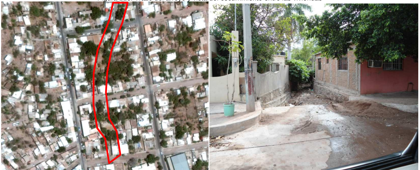
Figura 113. Trazo del arroyo y vista del escurrimiento entre las viviendas
