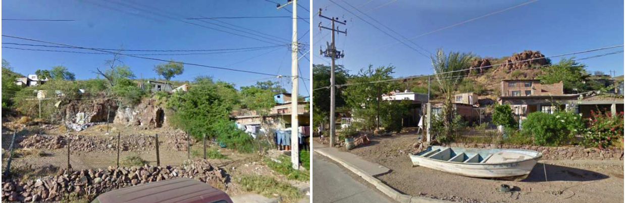
Figura 54. Viviendas asentadas en zonas de riesgo por deslizamientos, en las faldas del cerro Cabezón en la colonia Monte Lolita.
